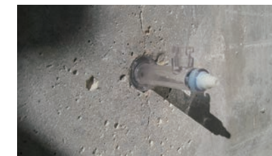
⑤ グラウトプラグSS打ち込み後
