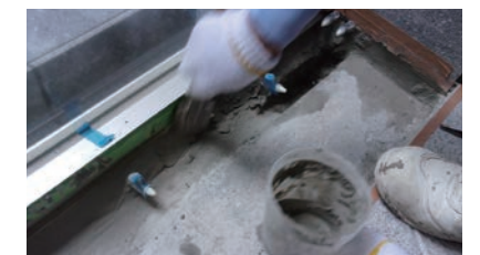
③ 仮止めシール（止水セメント）
