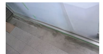
⑥ グラウトプラグSS撤去+仕上げ
