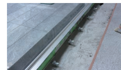
④ 仮止めシール硬化養生
