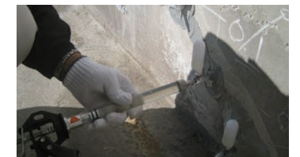
⑥ 仮止めシール+エポキシ樹脂注入
