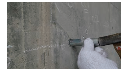
④ グラウトプラグSSの打ち込み
