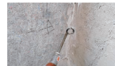
② 入隅凸部を撤去
