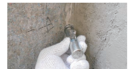
③ グラウトプラグSSの打ち込み
