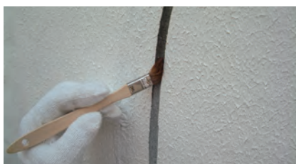
5. プライマー塗布
