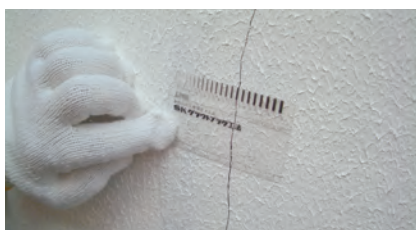
2. ひび割れ測定
