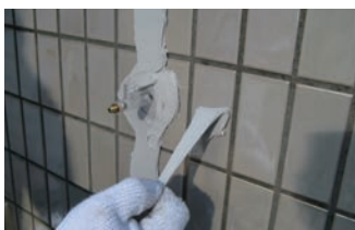
9. 仮止めシール材の養生と硬化確認
