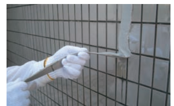
12. プラグと仮止めシール材の撤去
