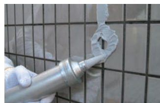
7. 仮止めシールの施工
