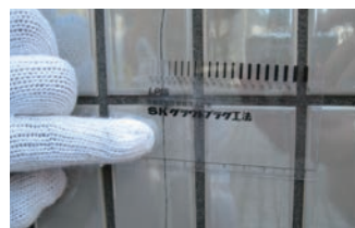
3. ひび割れ測定
