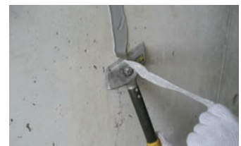
8. スクレーパー等で撤去し工事完了
