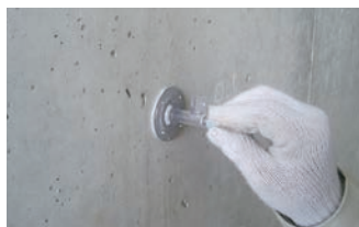
5. プラグ取付とひび割れシール
