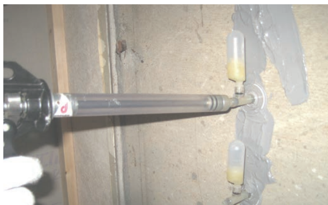
施工例：プラグ A 工法での仮止めシール材
