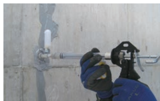
6. DFポンプによる注入
