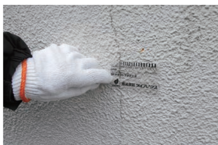
① ひび割れ測定
