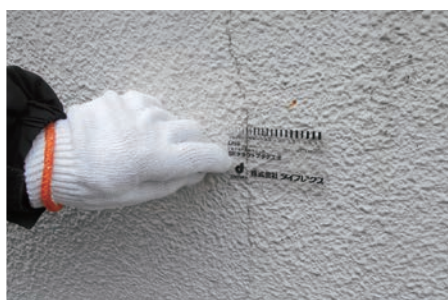
①ひび割れ測定
