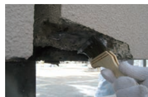
露筋欠損部のプライマー用途(SK モルタル)
