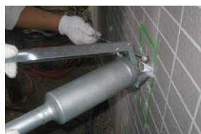
タイル直貼りの浮き部注入
