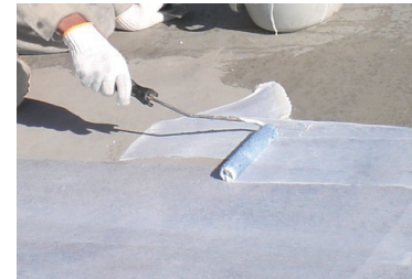
プライマー塗布
