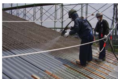
スレート屋根改修
