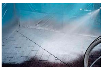
シングル屋根改修
