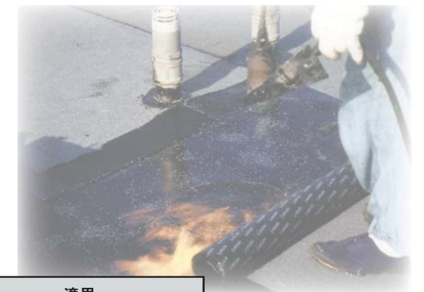
ダイナトーチDT-40 表層に天然スレート砂を施したトーチ工法用改質アスファルトシート。
