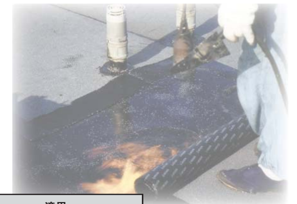
ダイナトーチDT-40 表層に天然スレート砂を施したトーチ工法用改質アスファルトシート。
