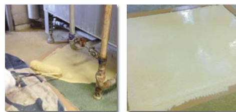
エバーフロアUW トップコート UW-T 厚み0.2～0.25mm
