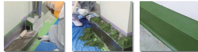
エバーフロアUW 立上り用 UW-V300 厚み3mm
