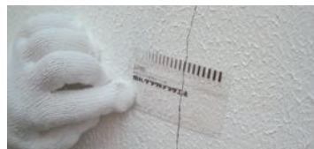
2. ひび割れ測定
