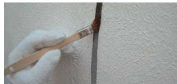
5. プライマー塗布
