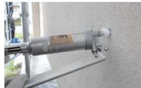
モルタルと躯体間の浮き部注入
