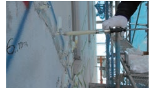
ひび割れ注入(建築外壁)
