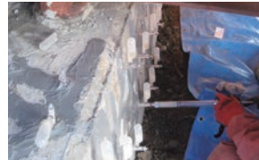
ひび割れ注入(橋台)
