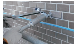
外壁タイル直張りの浮き部注入
