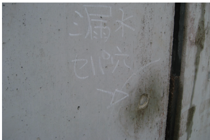
1. セパ穴 漏水状況
