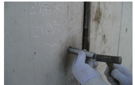
3. プラグSSの打ち込み
