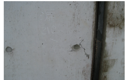
6. プラグ撤去：補修後
