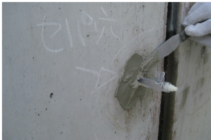
4. 仮止めシール (止水セメント)
