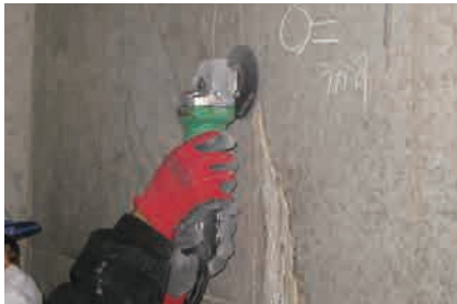
1. 施工前 (漏水状況)
