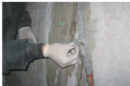
5. 止水セメントのシール
