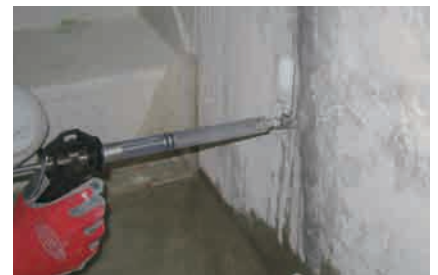
6. エバーボンド® SS#1 の注入
