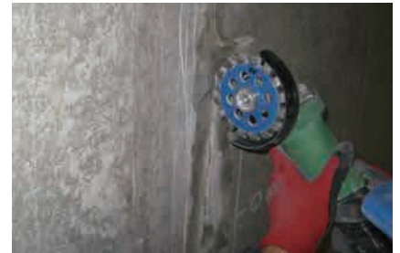
3. 漏水個所のカット
