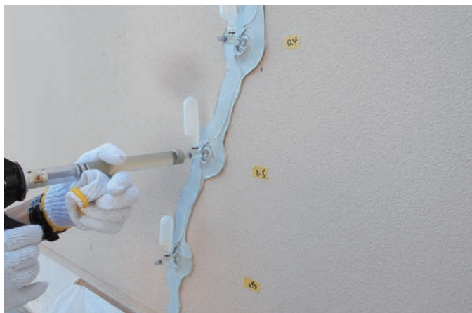
建築構造物 改修 外壁塗装面
