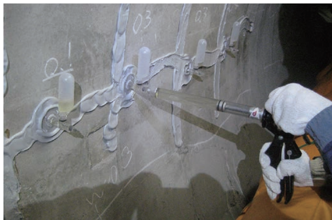
土木構造物 改修 地下ピット
