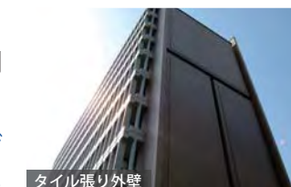
タイル張り外壁
