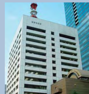
東京消防庁大手町本庁舎
