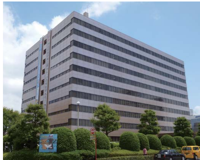
JA鹿児島県会館
