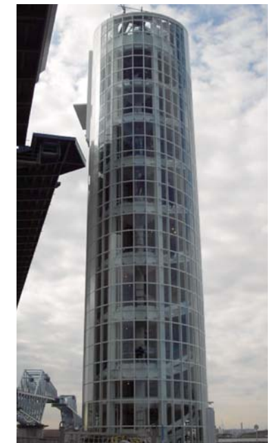
東京都港湾局 東京ゲートブリッジ
